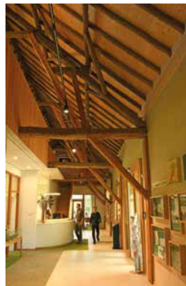
◀ Bij de verbouwing tot kantoor bleef de balkenconstructie van de oude schuur behouden.
