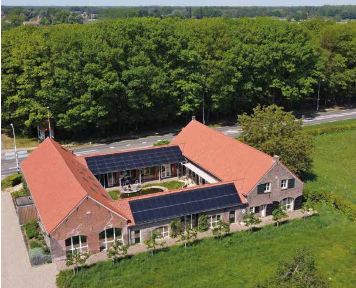
◀ Boerderij Kloosterhof is in gebruik als kantoor van Het Limburgs Landschap. Het is onlangs duurzaam verbouwd en heeft de energiestatus A++++!
